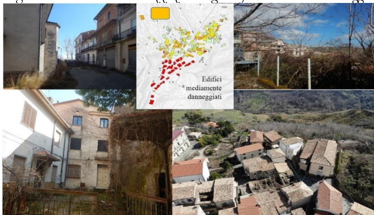
Fig. 6 – Sulla carta la localizzazione degli edifici mediamente danneggiati
