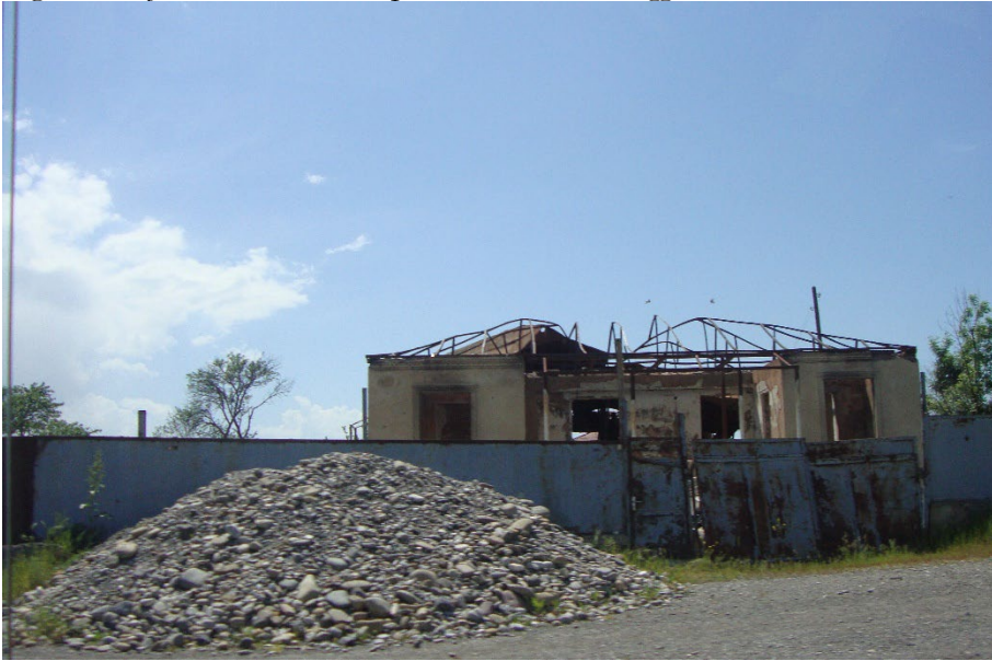
Fig. 1 - Edificio bombardato nei pressi di Gori, 18 maggio 2010
