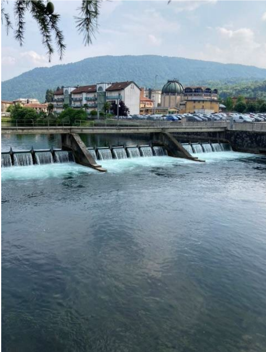
Fig. 2 – La traversa mobile sul Fiume Tresa realizzata in base alla convenzione italo-svizzera del 1955 concernente il Lago di Lugano
