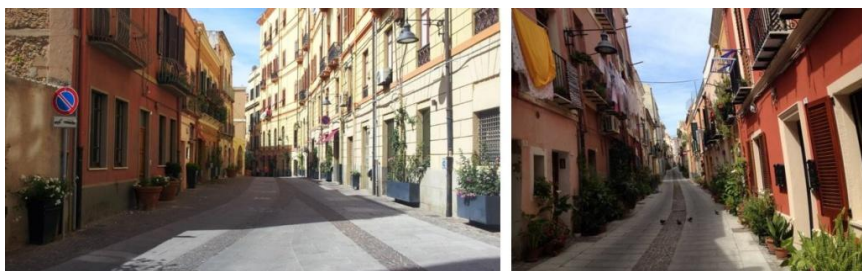
Fig. 3 – Esempi di riqualificazione stradale ed edilizia in via Sulis e in via S. Giovanni
